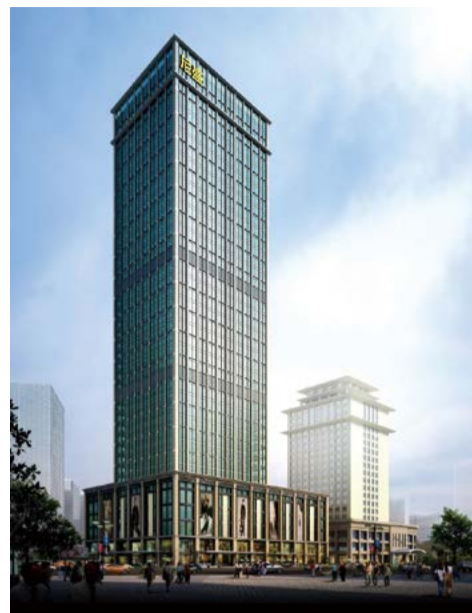
苏州尼盛广场项目
