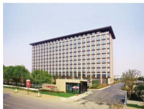
苏州莱克厂房项目
